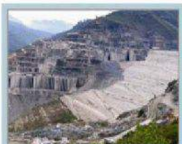
ГЭС Тери в Индии
