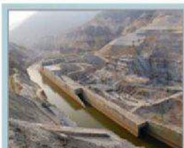
Строительство ГЭС Лай Чау во Вьетнаме, общий вид, 2013 год.
