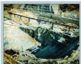
ГЭС Лай Чау во Вьетнаме. Котлован здания ГЭС
